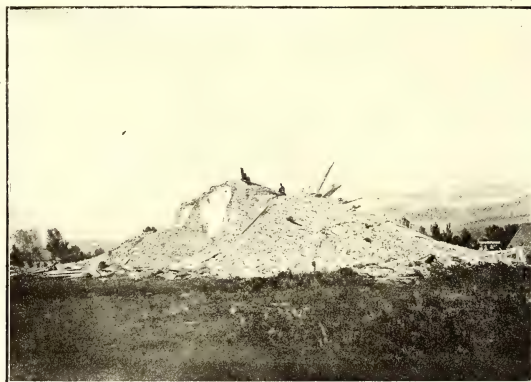
Покровская церковь, разрушенная землетрясеніемъ 23-го мая 1887 г.
